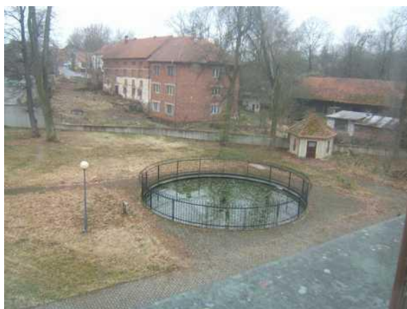
Nádrž na zahradě sloužící jako požární nádrž
