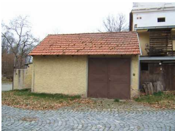
Garáž na pozemku č.parc. st. 198
