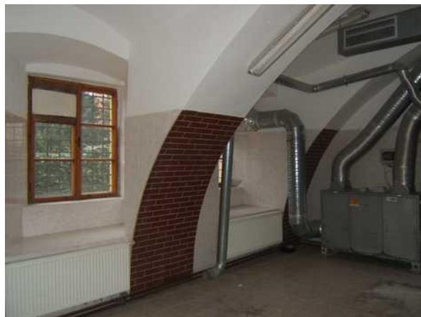
Prostory prádelny v přízemí zámku
