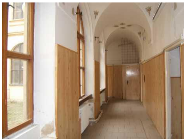
Chodba v přízemí kopírující nádvoří
