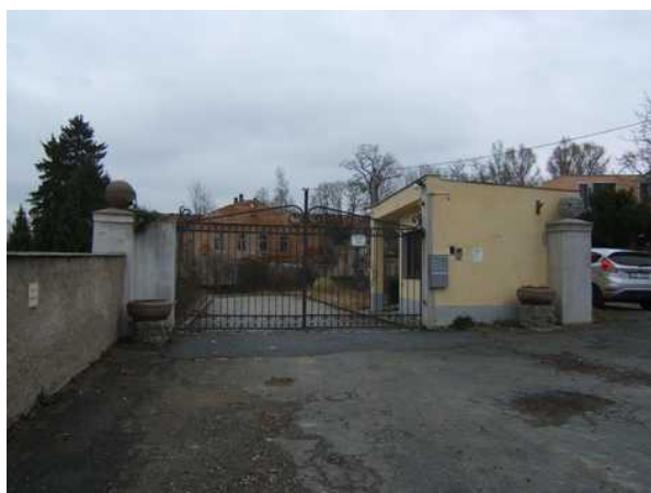
Vjezd do areálu zámku po pozemku č.parc. 381/11
