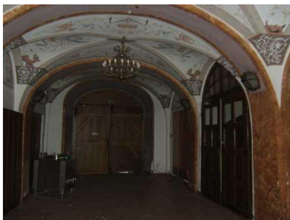
Průjezd na nádvoří s dveřmi na schodiště
