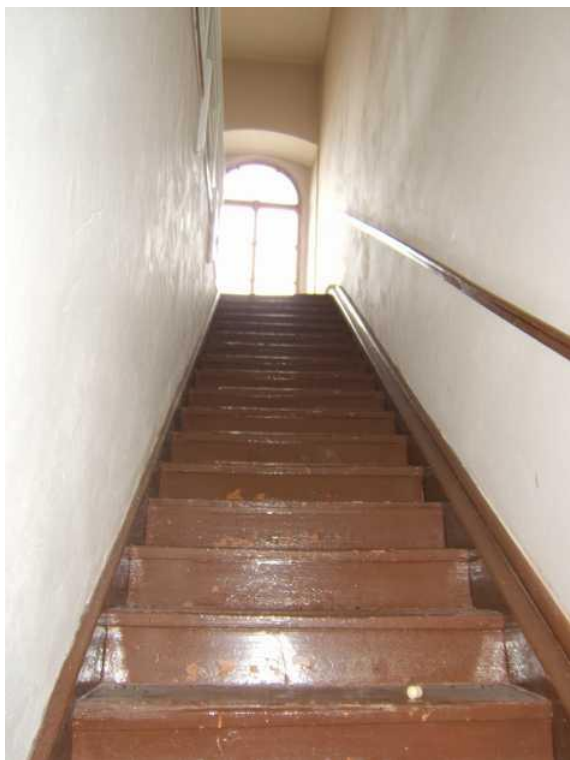
Schody do věže v severozápadním nároží zámku
