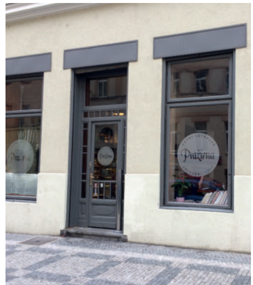
Označení provozovny formou decentního typografického polepu dvěma a okna.
