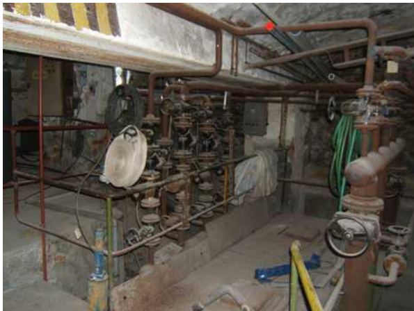
Nefunkční kotelna ve sklepě zámku
