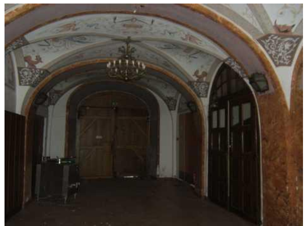
Průjezd na nádvoří s dveřmi na schodiště
