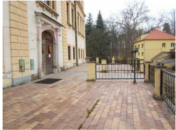
Terasa před vchodem do zámku - střecha přistavené kotelny
