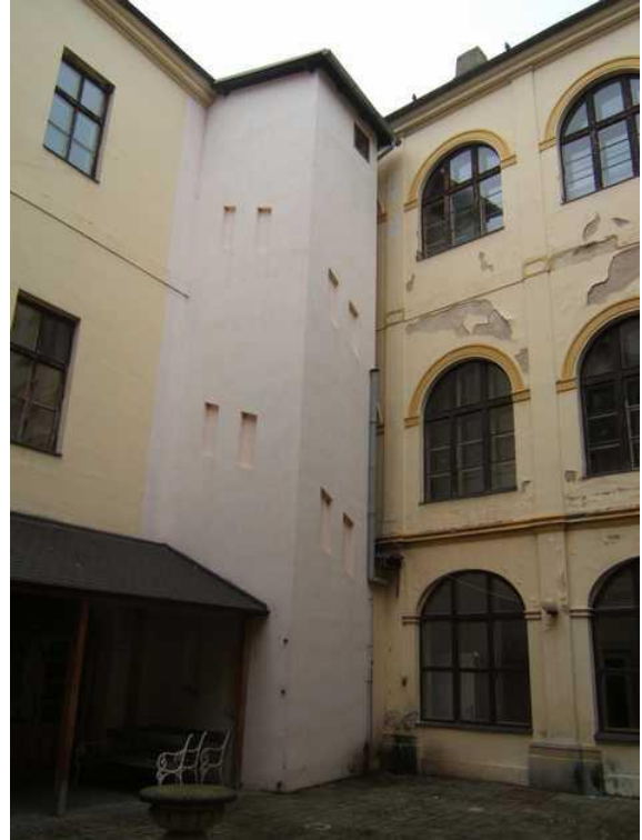
Přístavba výtahu do nádvoří a dřevěný přístřešek na nádvoří
