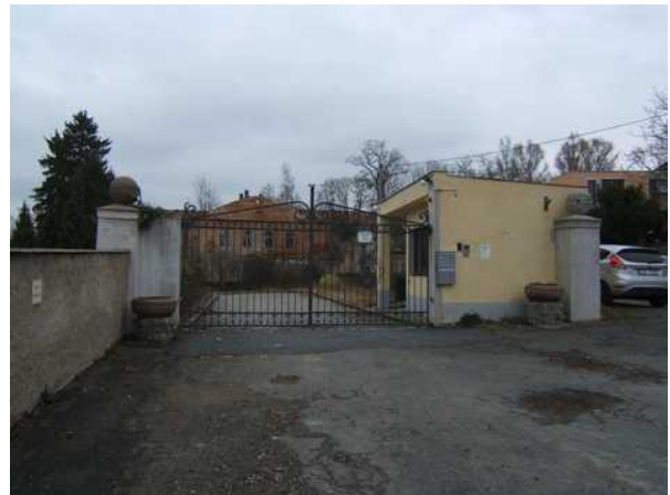
Vjezd do areálu zámku po pozemku č.parc. 381/11
