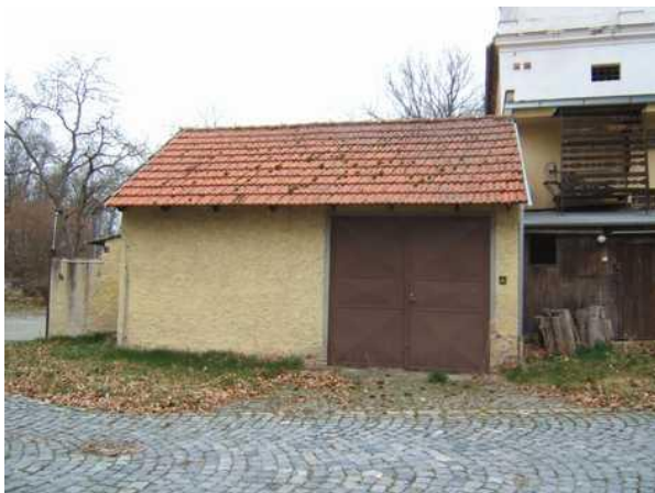
Garáž na pozemku č.parc. st. 198
