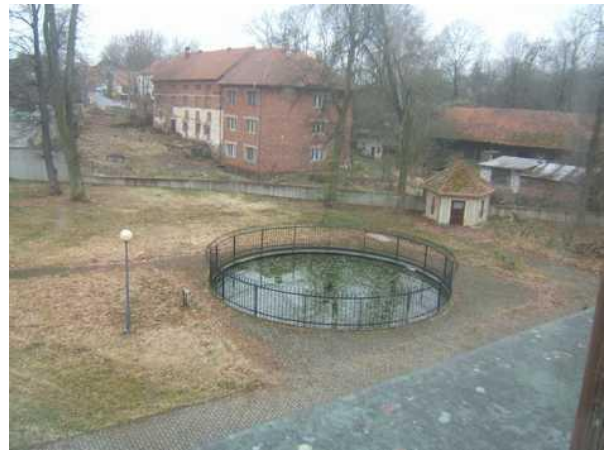
Nádrž na zahradě sloužící jako požární nádrž
