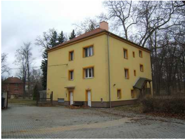
Pohled na ubytovnu na pozemku č.parc. st. 192 ze severovýchodní strany
