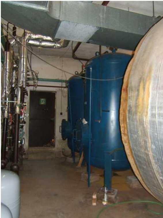
Vybavení elektrokotelny umístěné pod terasou
