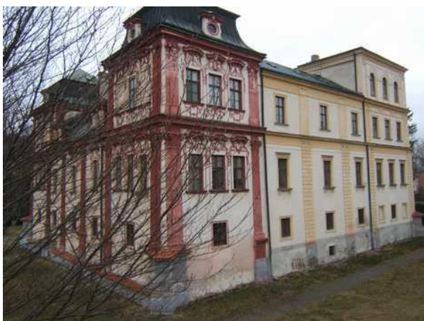
Pohled na zámek z příjezdové komunikace na hrázi Svojsického rybníka
