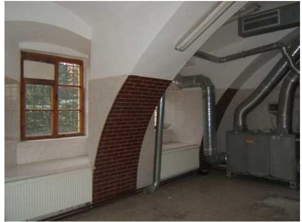
Prostory prádelny v přízemí zámku
