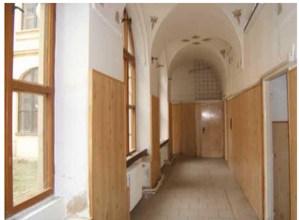
Chodba v přízemí kopírující nádvoří
